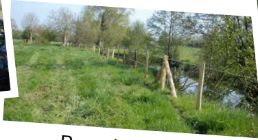
Pose de clôtures (source CSN)
