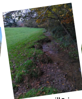
Corneville : berge érodée (source CSN)
