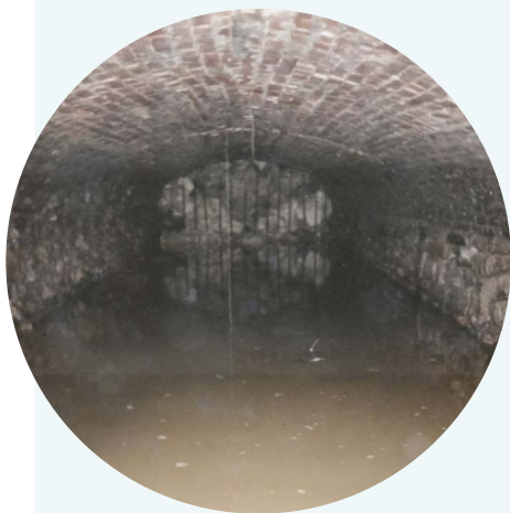
Redécouverte du bief lors des travaux du cœur de bourg (ville de BSL)
